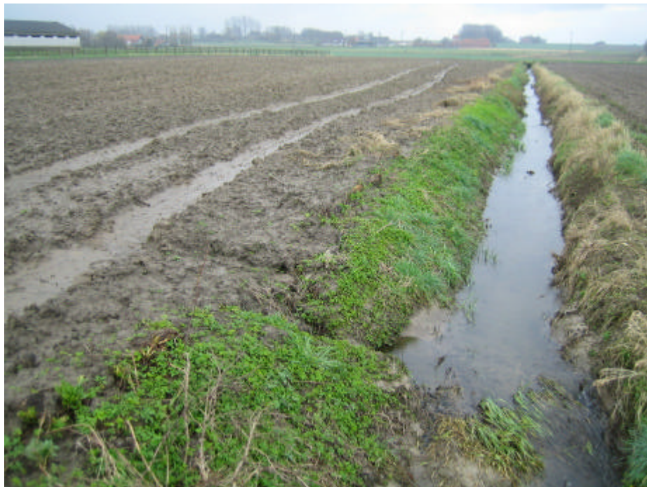
Foto 4.91: Doorbraak van de oever aan perceel 81089
