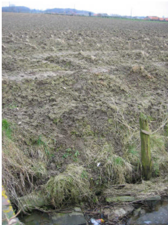
Foto 4.38: Onstabiele oever aan de Biestbeek ter hoogte van perceel 81331
