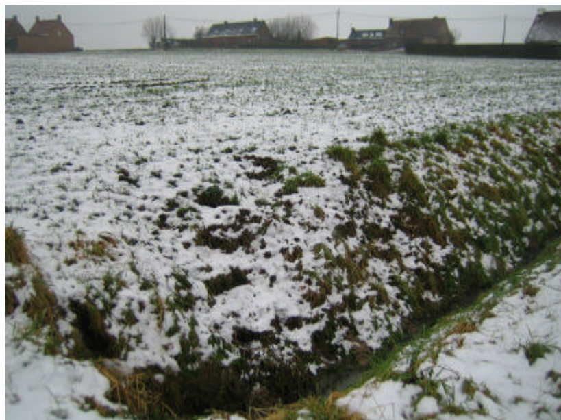
Foto 4.1: Onstabiele grachtrand aan perceel 70459
