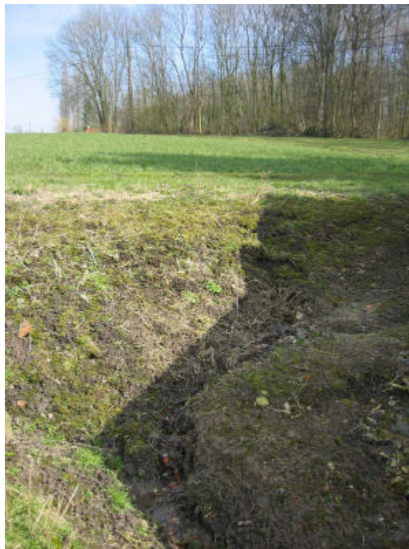
Foto 4.101: Doorbraak talud van perceel 76605
