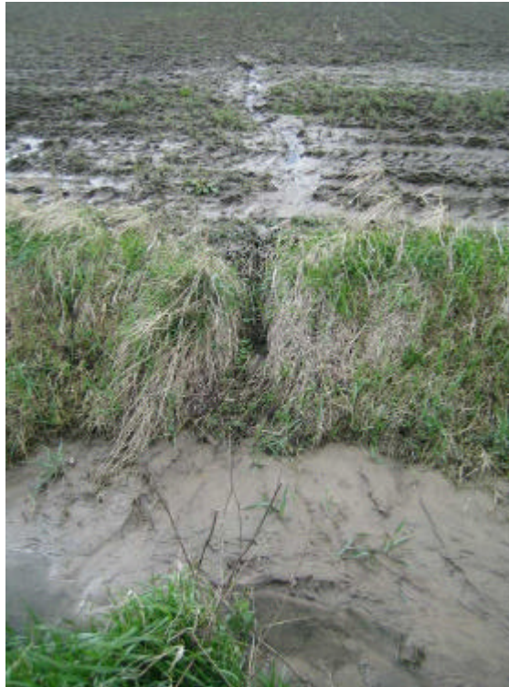
Foto 4.108: Doorbraak van de grachtkant op perceel 76544a met depositie in de gracht tot gevolg
