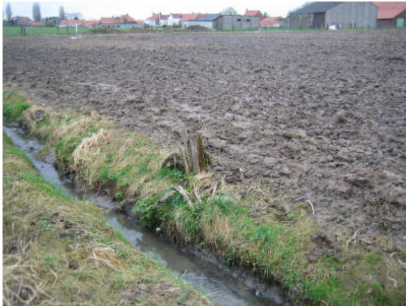
Foto 4.43: Onstabiele grachtkant aan perceel 81378
