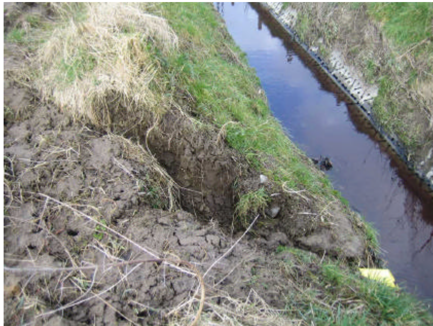
Foto 4.34: Doorbraak van de oever van de Nederbeek ter hoogte van perceel X2_A11
