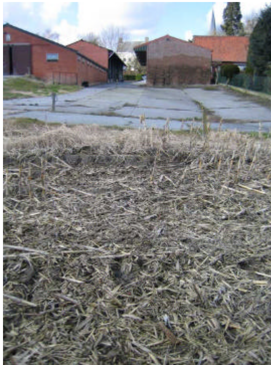
Foto 4.73: Betonverharding bovenaan perceel 83625
