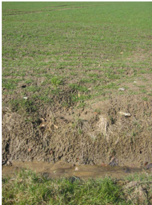
Foto 4.100: Onstabiele grachtkant aan perceel 83515
