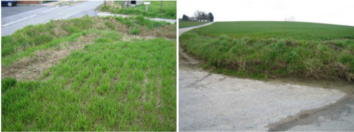
Foto 4.76: Aangelegd dammetje ter hoogte van perceel 76707 en hoek Tjampenstraat/Leemstraat
