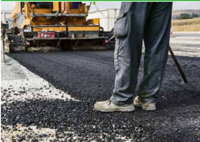
Voor de werken aan de Oudenaardestraat werken we met een omleiding.
